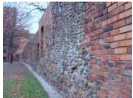
Berlin-Mitte: Reste der Stadtmauer
